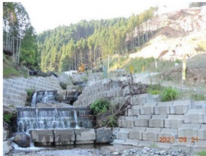
写真-6.6 溪流の床固工
