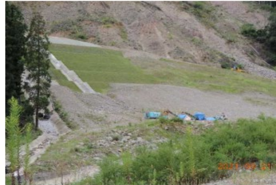
写真-1.11 十編組ハ横土盛土工
