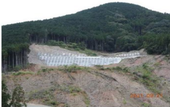
写真-1.8 「法枠工+アンカー工」による抑止工
