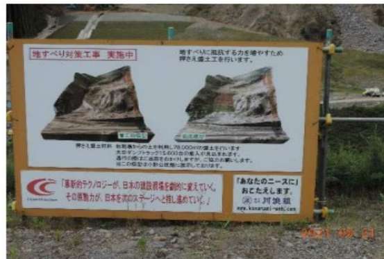
写真-1.9 押さえ盛土工の解説(現場設置)
