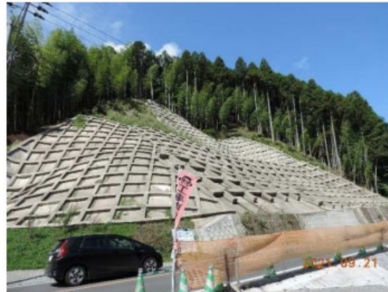
写真-3.5 崩壊防止工での復旧状況
