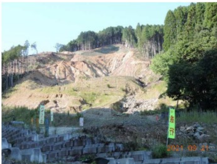
写真-6.5 崩壊防止工が実施されている現場
