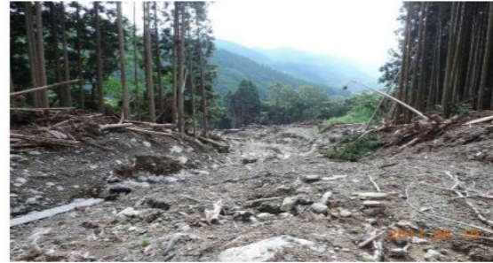
写真-2.18 砂防堰堤より下流域を望む
