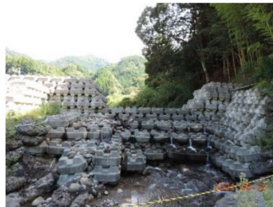
写真-2.7 ブロック積み仮復旧堰堤 前面
