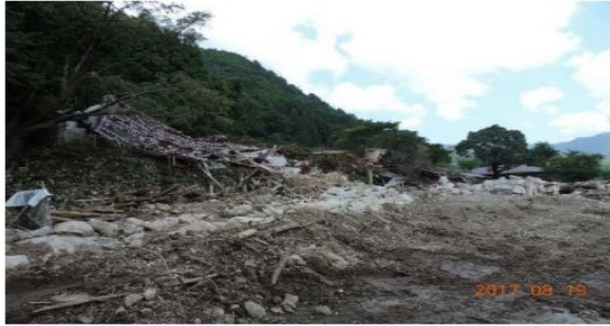
写真-2.15 道路直上斜面への土砂岩塊の堆積
