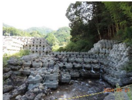
写真-2.7 ブロック積み仮復旧堰堤 前面
