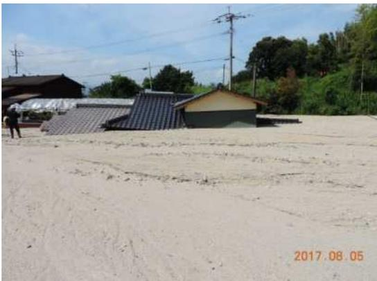
写真-5.1 下流域の土砂の堆積状況
