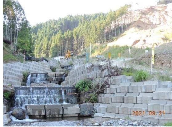
写真-6.6 溪流の床固工
