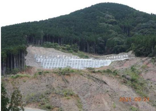
写真-1.8 「法枠工+アンカー工」による抑止工
