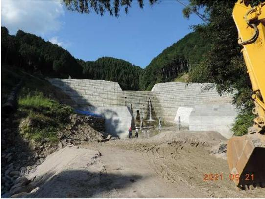
写真-5.3 新たに整備された砂防堰堤
