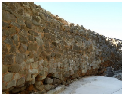
写真-2 天川が使用された石積み護岸
