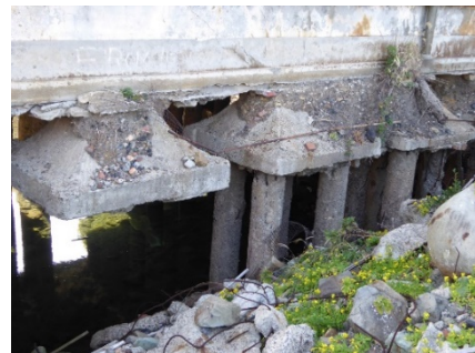
写真-1 旧端島小中学校基礎部の状況
