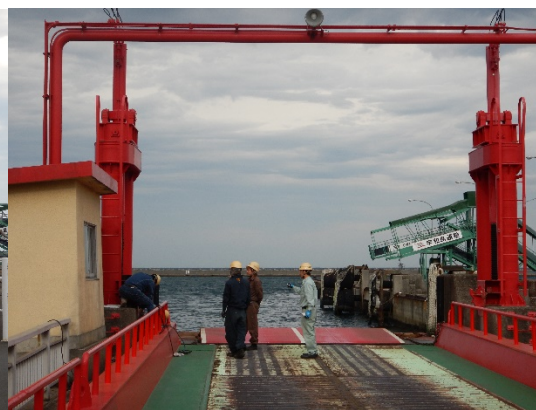
写真-7 車両乗降施設の修理作業状況
