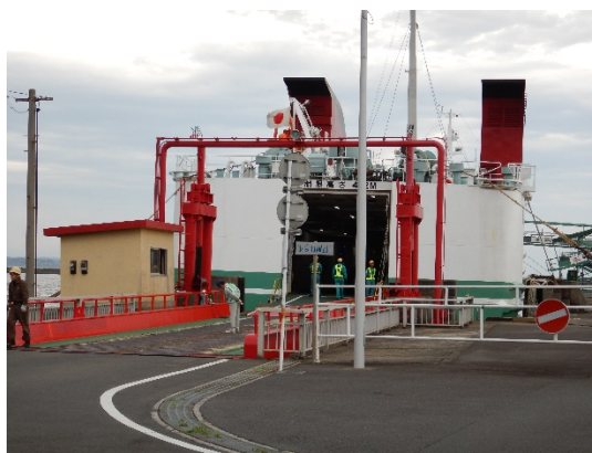
写真-6 フェリーの接岸状況
